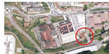
En rojo, los caseríos objeto de demolición
